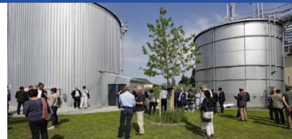
Fermentador y tanque de almacenamiento de energía
