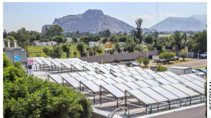
“Calentadores solares de agua instalados en el techo de un edificio público de la Ciudad de México”
