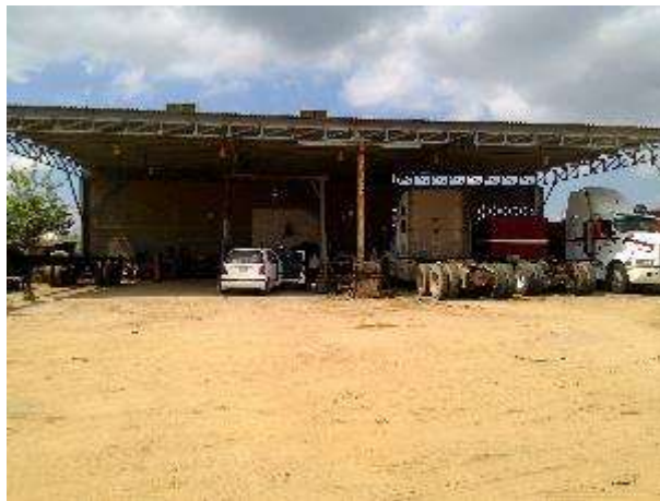
Áreas de mantenimiento y patio de la empresa B
