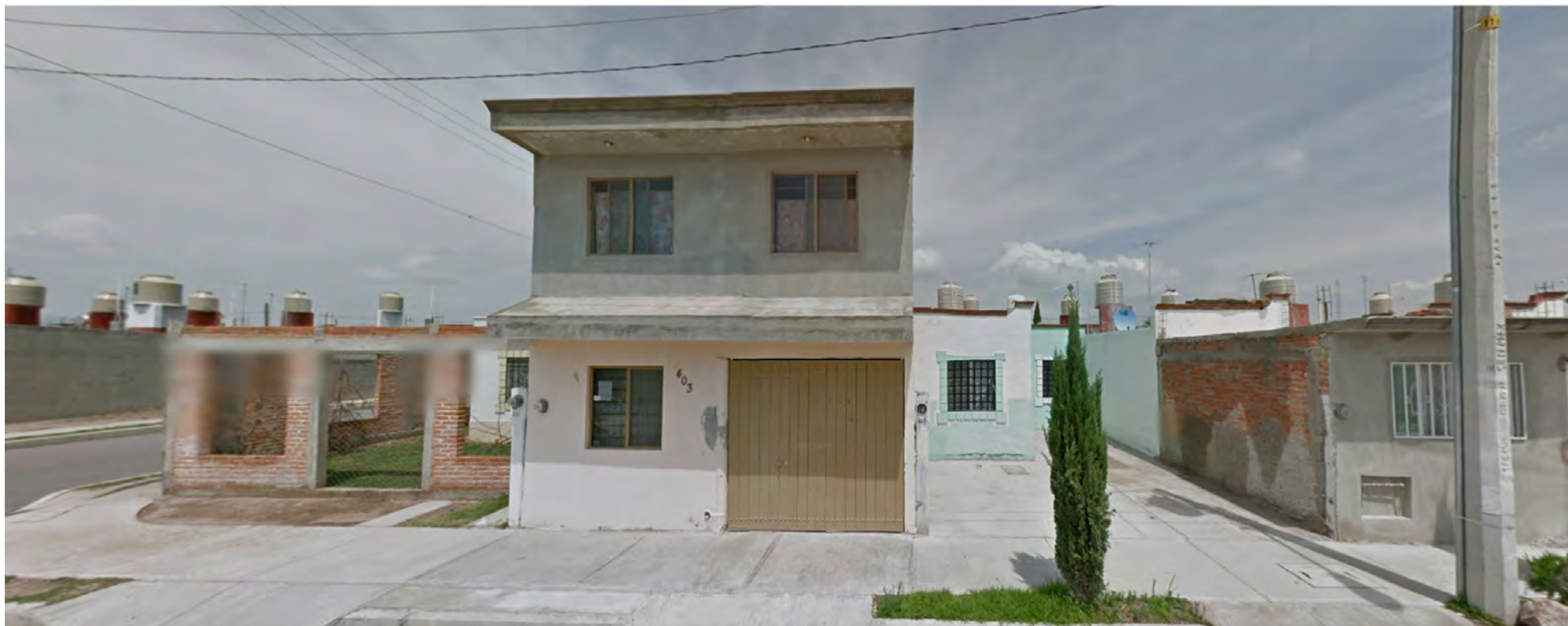
vivienda adosada ampliación horizontal y vertical paseos de hule, aguascalientes
