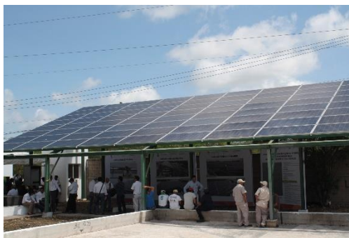
Fig 2. Paneles fotovoltaicos instalados en plantas de tratamiento de aguas residuales del Gobierno
