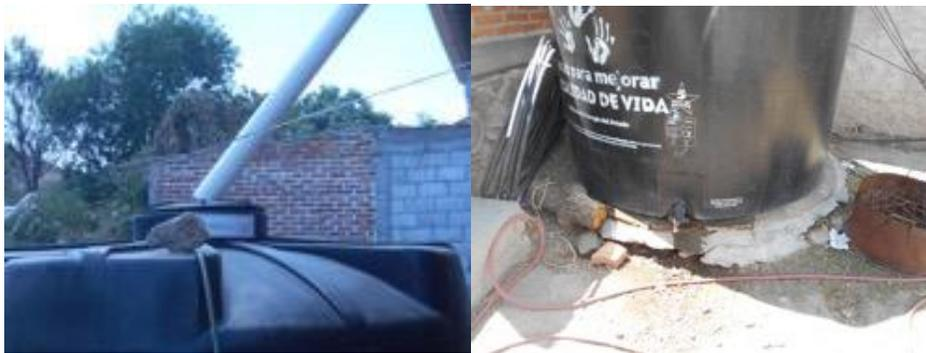
Fotografía 5. Posición de tubería y fuga en llave de tinaco
