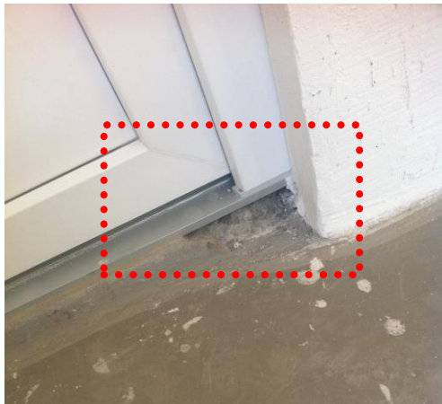
Imagen 25.- Infiltración por sellado exterior insuficiente.
