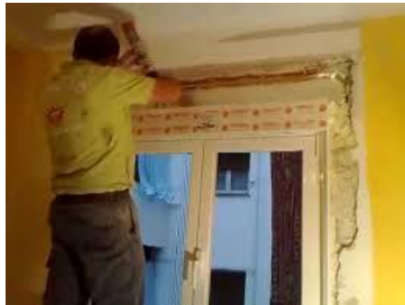
Imagen 30.- Colocación de carpintería de PVC
