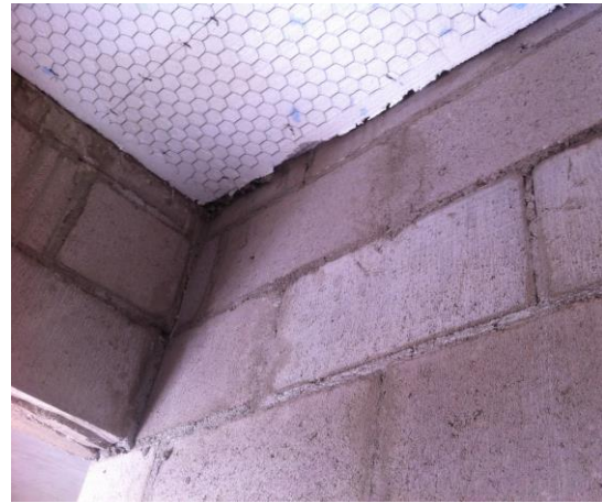
Imagen 36.- Unión entre muro y losa de azotea vista interior.
