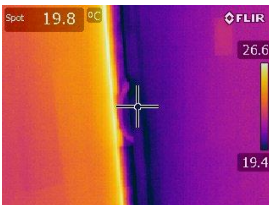
Imagen 66. Infiltración por carpintería.
