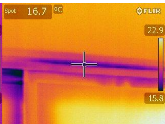
Imagen 67. Infiltración por carpintería.
