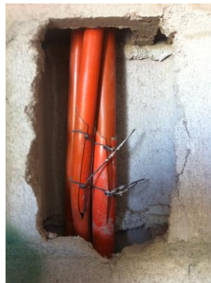
Imagen 55.- Uniones de tubos de Electricidad
