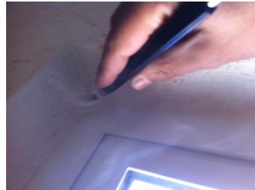
Imagen 75.- Infiltración unión carpintería con muro.
