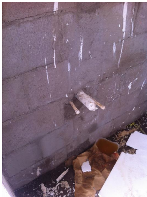
Imagen 13.- Paso y recibido de instalaciones de fontanería.
