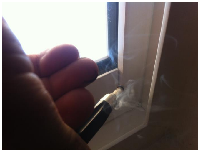
Imagen 73.- Infiltraciones por carpinterías
