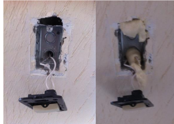
Imagen 54.- Infiltración entre base de contacto y muro
