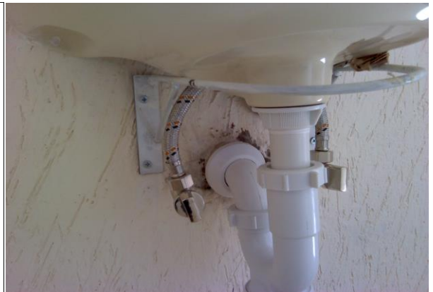
Imagen 48.- Aire de infiltración en la unión desagüe de lavabo en la unión con el muro de bloque. Solución sellado con silicona.
