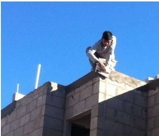
Imagen 33.- Remate entre bloque y losa del sistema constructivo convencional.
