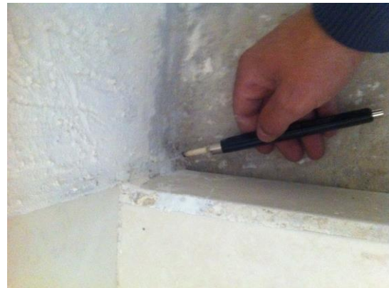
Imagen 38.- Infiltración encuentro losa cimentación y muro de fachada.
