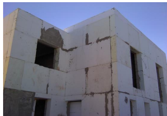
Imagen 45.- Efecto chimenea y puentes térmicos.
