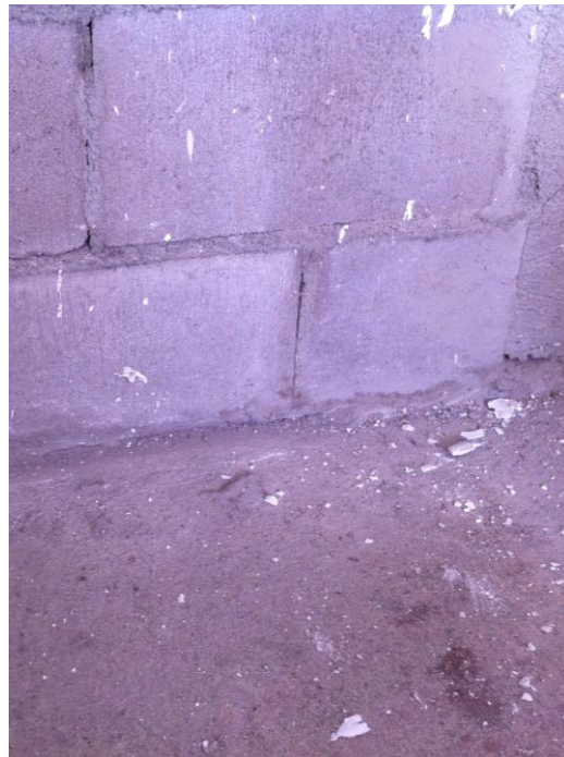
Imagen 15.- Unión de muro con losa de cimentación.
