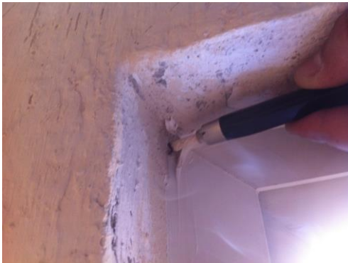
Imagen 74.- Infiltración en unión de carpintería con muro.
