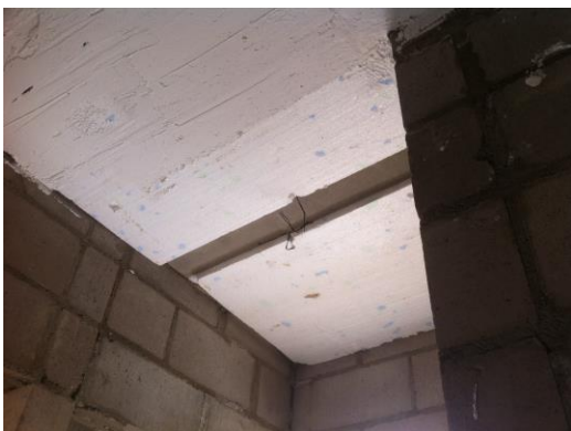
Imagen 16.- Ejecución de losa de azotea. Vista interior .
