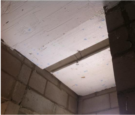
Imagen 35.- Unión entre muro y losa de azotea Vista interior.
