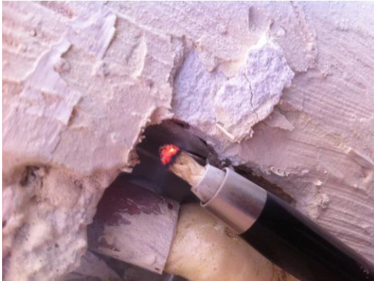
Imagen 53.- Infiltración entre base de contacto y muro
