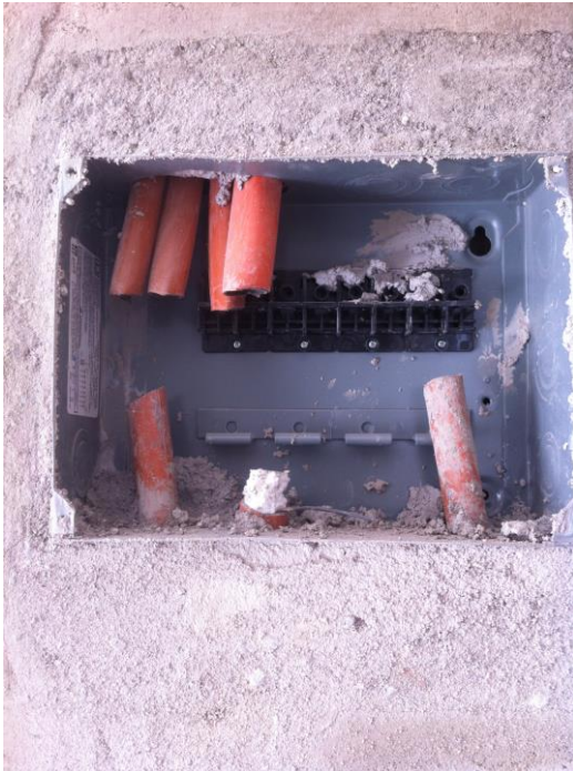
Imagen 14.- Cuadro de Mando y Protección Eléctrico .
