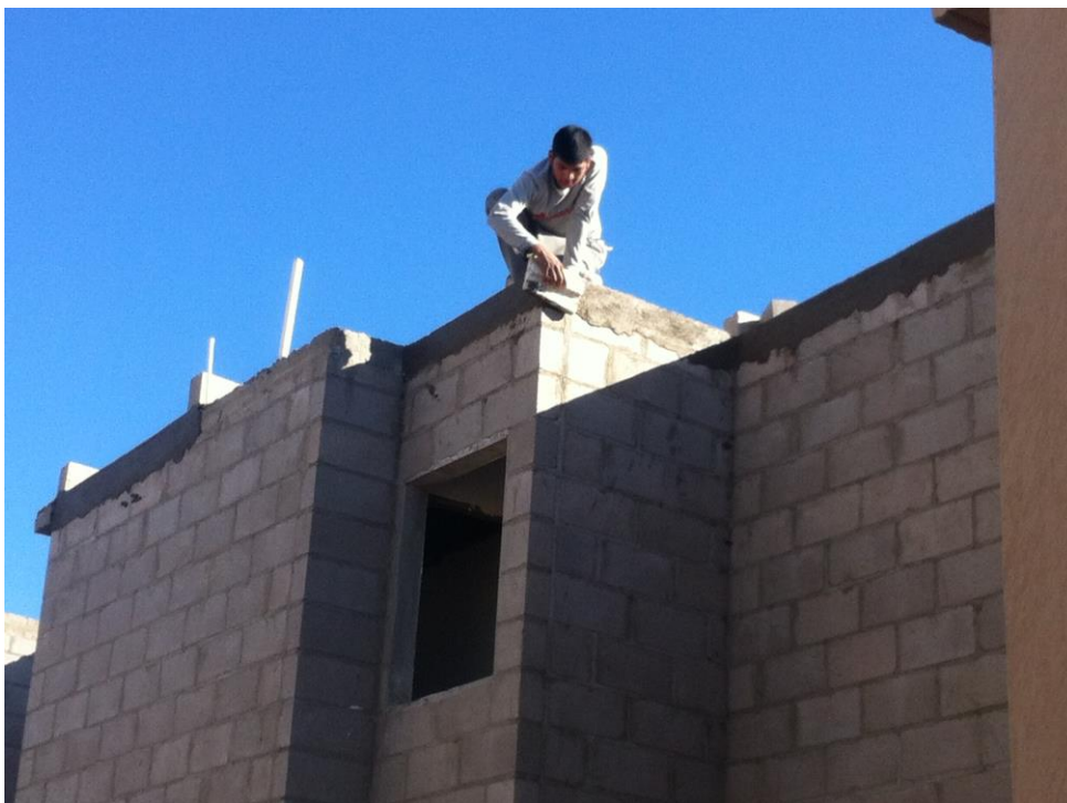
Imagen 9.- Remate de unión de losa de cubierta con muro de fachada.
