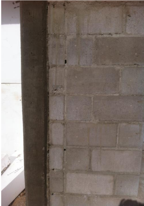
Imagen 10.- Unión en esquina de muros.
