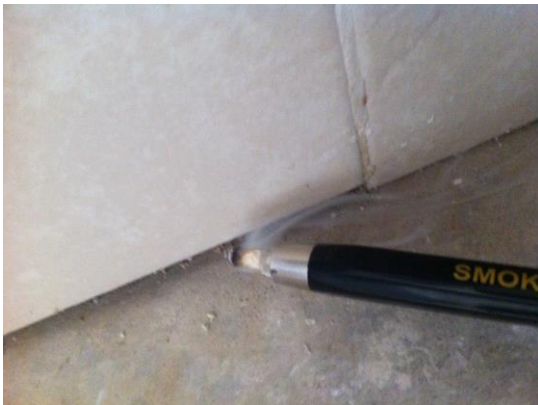
Imagen 37.- Infiltración encuentro losa cimentación y muro de fachada.
