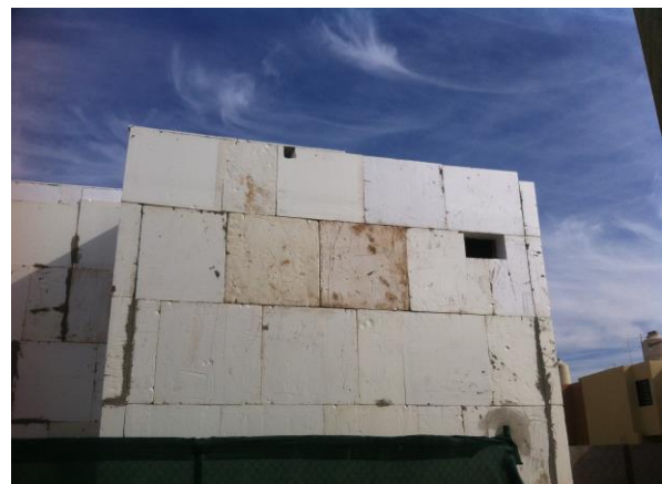
Imagen 41.- Falta de continuidad en material aislante.
