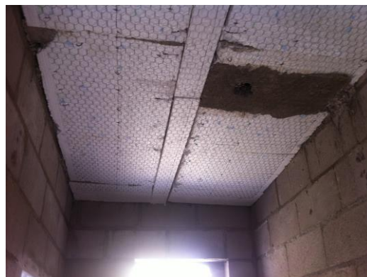
Imagen 17.- Vista interior de losa azotea .
