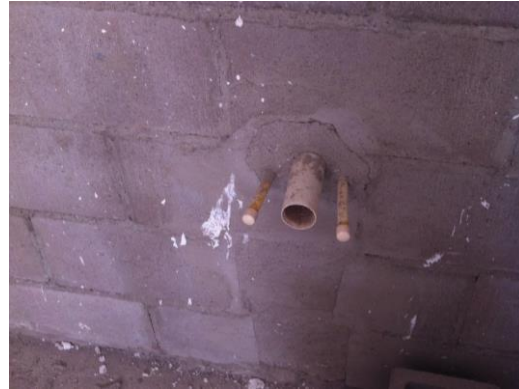
Imagen 21.- Paso y recibido de tuberías saneamiento.
