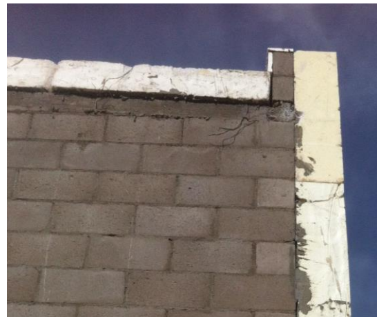
Imagen 34.- Solución constructiva para la colocación de aislamiento térmico exterior.
