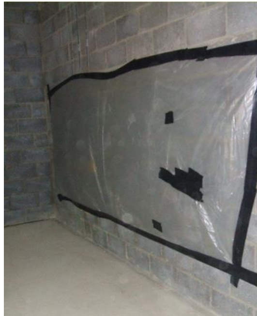
Imagen 27.- Ensayo para comprobar la permeabilidad al aire de las fabricas de bloque.
