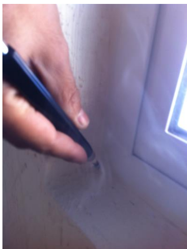
Imagen 72.- Infiltración por carpintería
