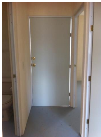
Imagen 82.- Puerta de salida a patios provisionales de viviendas Nama de 46 m2
