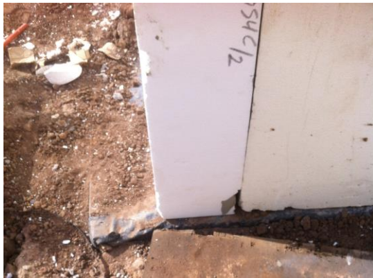
Imagen 42.- Falta de material aislante entre bloques de aislamiento, encuentro entre fachada y cimentación.
