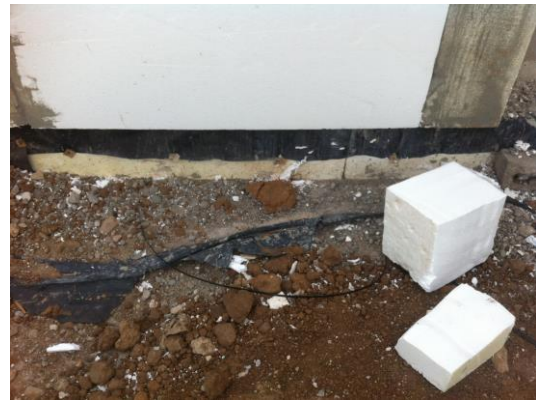
Imagen 43.- Falta de material aislante entre bloques de aislamiento entre fachada y cimentación.
