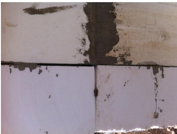
Imagen 40.- Falta de continuidad del aislante de muro.
