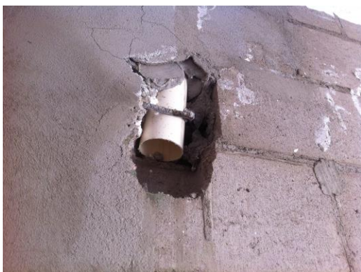
Imagen 18.- Vista interior de tubo para paso de instalación de aire acondicionado.
