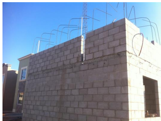
Imagen 19.- Interrupción de muro de para colocación de tubo de paso de instalación de aire acondicionado.
