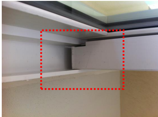
Imagen 62.- Separación entre la hoja y el marco
