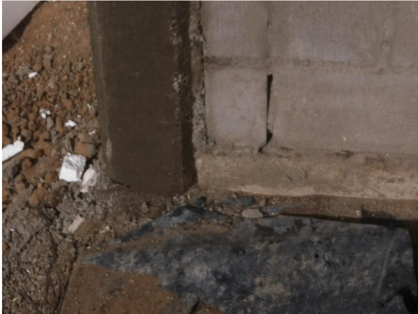
Imagen 39.- Unión fría entre losa de cimentación y muro de bloque.
